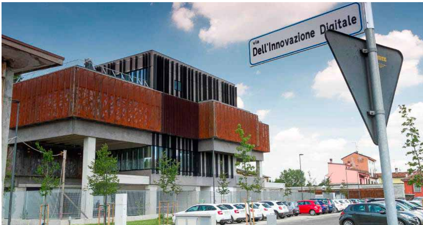
Il Polo per l'innovazione digitale: l'edificio si estende su un'area di oltre 13.000 metri quadrati, domani l'inaugurazione e la festa della tecnologia
